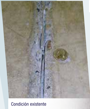
Cortes realizados por fuera del daño de la junta
